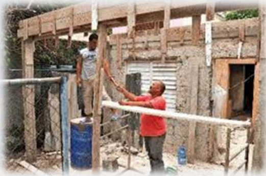
Construcción de vivienda
